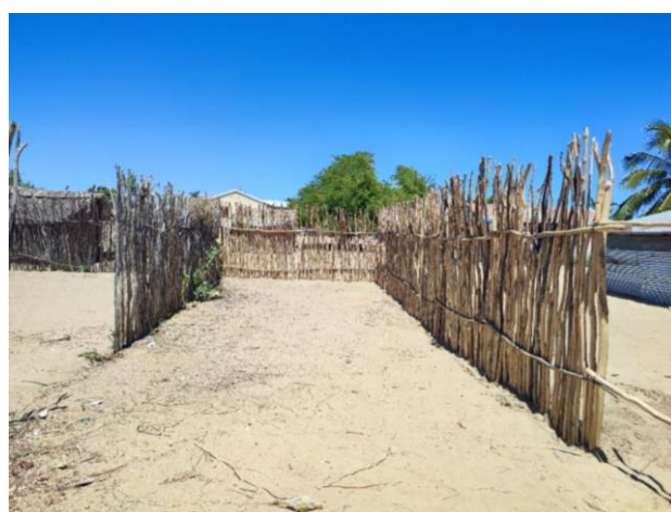
On a agrandi l'espace au fond de la cour par l'achat d'une bande de terrain, nécessitant aussi une nouvelle clôture traditionnelle.
