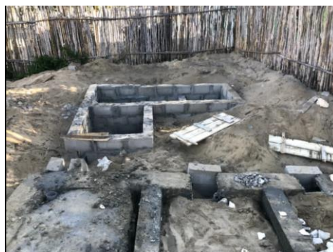
Un petit bloc sanitaire est en construction actuellement
