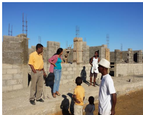
Yolande FRANÇOISE visite avec le pasteur RAMANA le chantier de l'école d'Andranomena .
