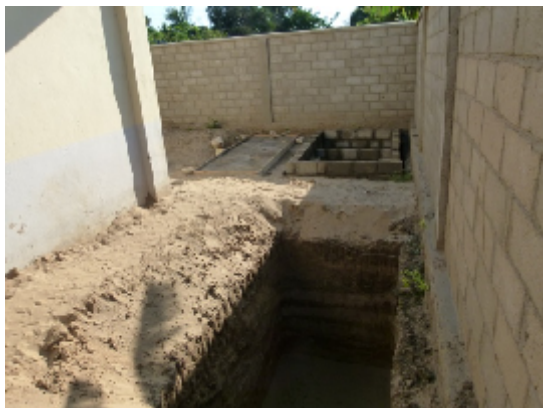
Fosse septique en construction
